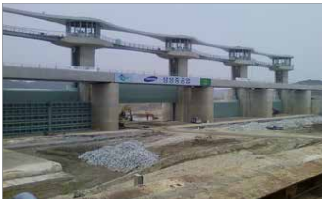
Positionsmessung von Schleusentoren
